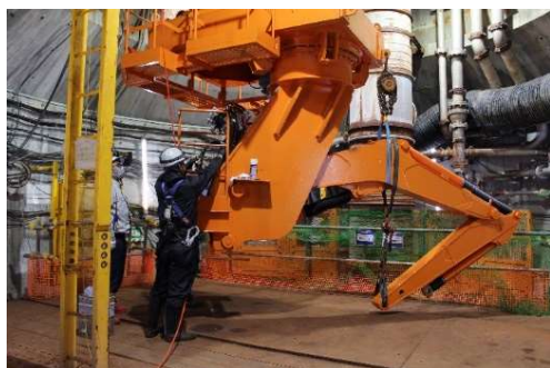
積込機の整備
