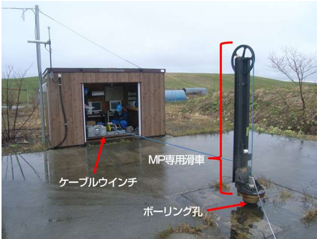
観測装置の回収・挿入時の様子
