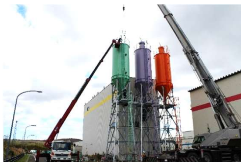
セメントサイロの設置
