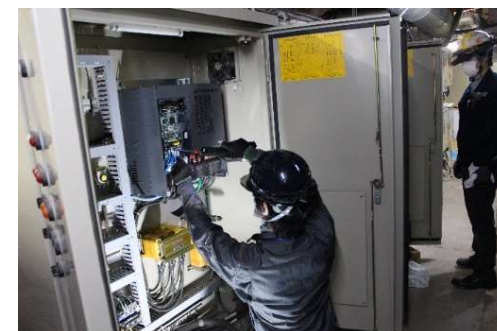
排水設備の更新
