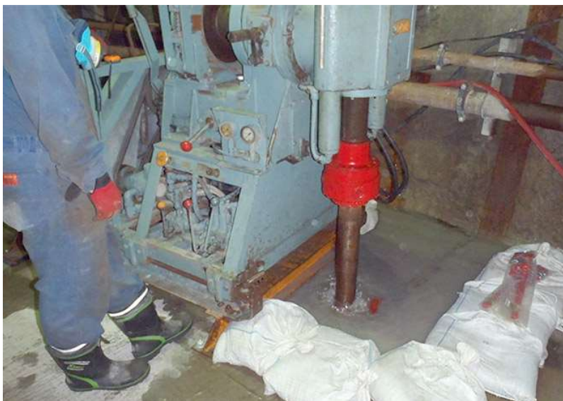
ボーリング孔の掘削の様子
